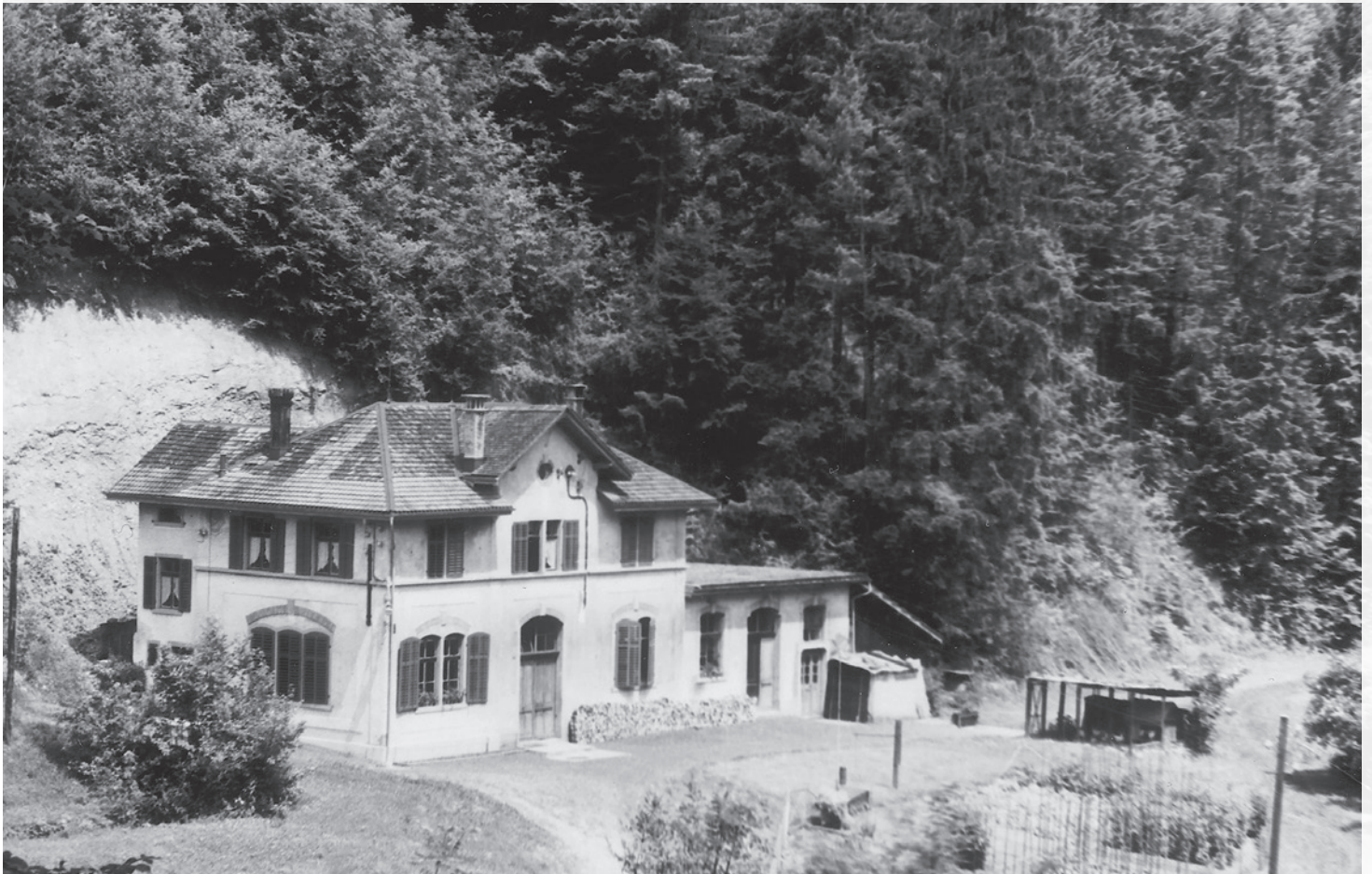
Maschinenhaus am Tobelausgang (1955); ebenerdig die Kraftwerkzentrale mit allen Nebeneinrichtungen und darüber die Dienstwohnung für den Maschinisten.
