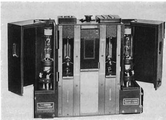
Bild 3: Zweistufiger Niederfrequenzverstärker (1914).
